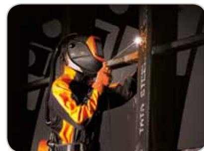
Spawanie w trudnych warunkach na placach budowy i w terenie
